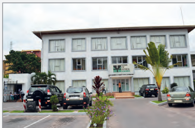
La cour intérieure du Siège de la BOA-RDC à Kinshasa. The courtyard of the BOA-RDC headquarters in Kinshasa.
