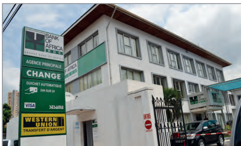
Siège de la BOA-RDC, à Kinshasa. The BOA-RDC Head Office, in Kinshasa.
